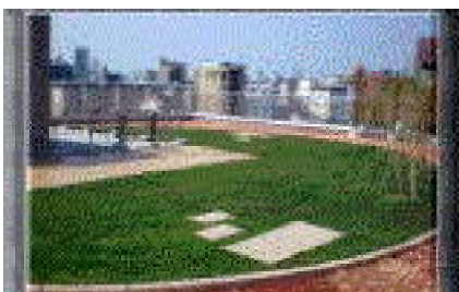
屋上緑化施工例(当社写真提供)
